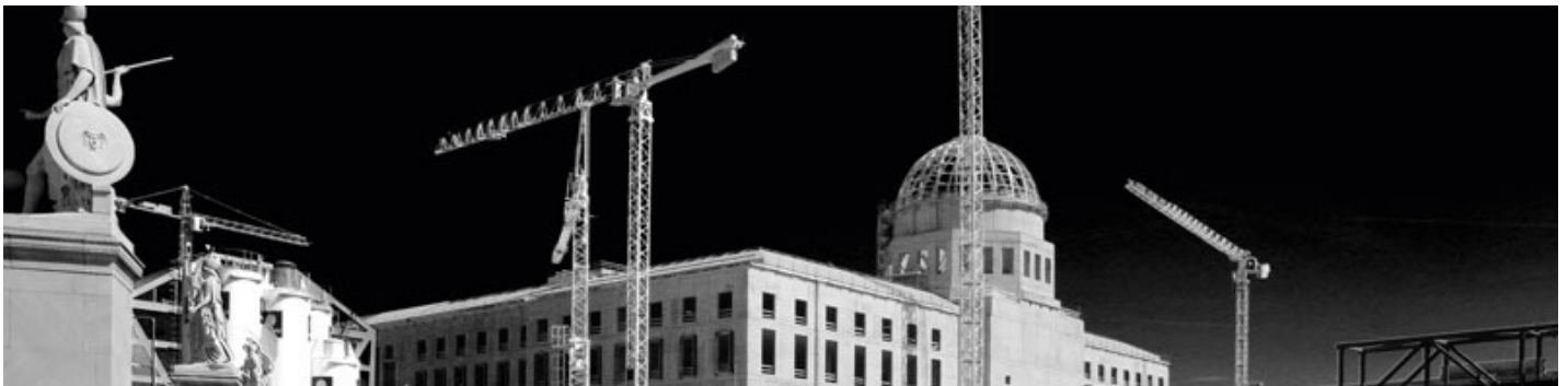
Große Baustelle für einen großen Bau: der Neubau des Stadtschlosses in Berlins Mitte | Foto: Nennstiel
