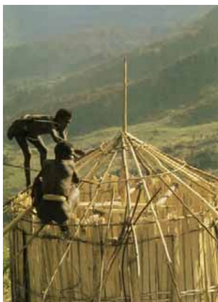
Finishing the seemingly chaotic construction of the house. Quelle: Koch, Gerd 1984. Malingdam. Ethnographische Notizen über einen Siedlungsbereich im oberen Eipomek-Tal, zentrales Bergland von Irian Jaya (West-Neuguinea), Indonesien. Berlin: Reimer, p. 40.
